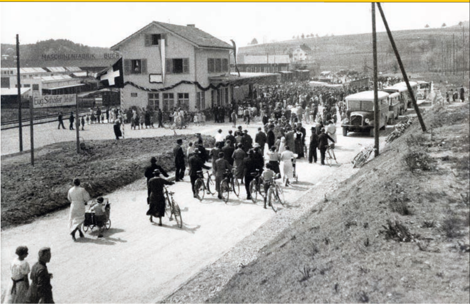
Einweihung der neuen Stationsanlage in Niederweningen am 15. Mai 1938 © Firmenarchiv Bucher
